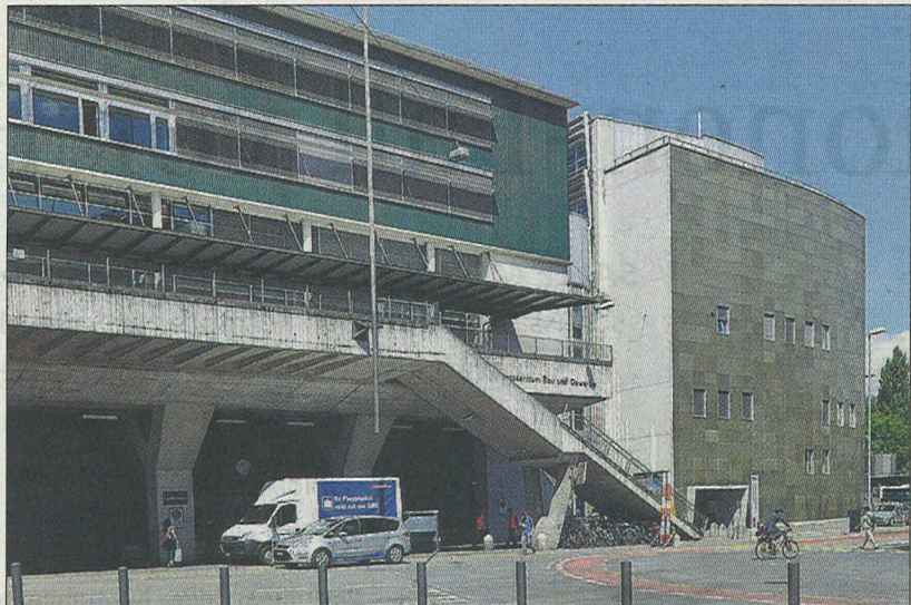
Hauptbahnhof, Ostportal: Der heutige Zugang (rechts hinter der Treppe) wird 15 Meter nach links verlegt – dorthin, wo auf dem Bild ein blauer Lieferwagen steht.
